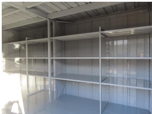
防災倉庫の中
